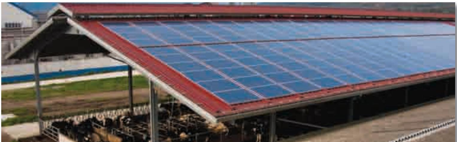
*Impianto FV su pannello isolante Isopan ISOCOP*
