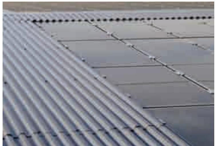
Integrazione totale con lamiera grecata Isopan LG 28 (progetto FV: Energetics s.r.l.)
