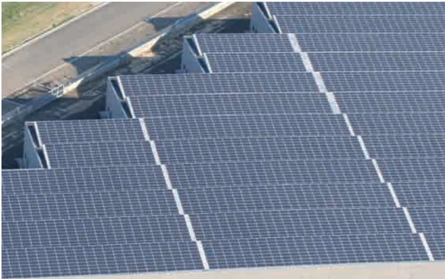
*Moduli FV installati su copertura in lamiera grecata Isopan LG 40 (progetto FV: Gesuina Energy di Oristano)*
