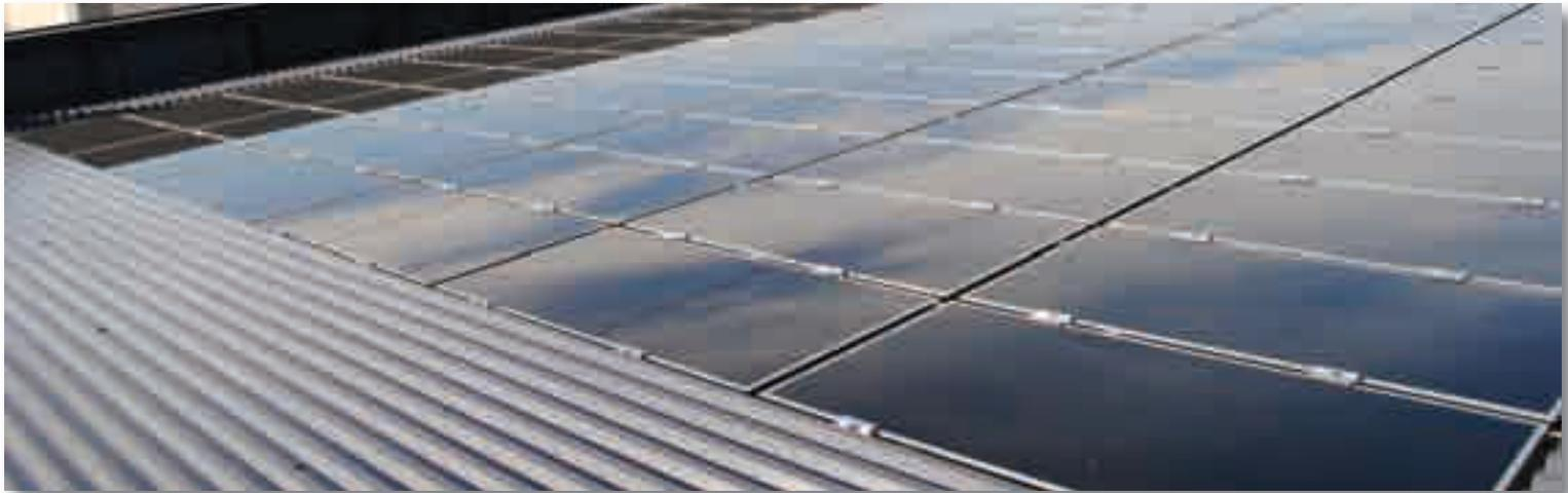
*Impianto FV con lamiera grecata Isopan LG 28 (progetto FV: Energetics s.r.l.)*
