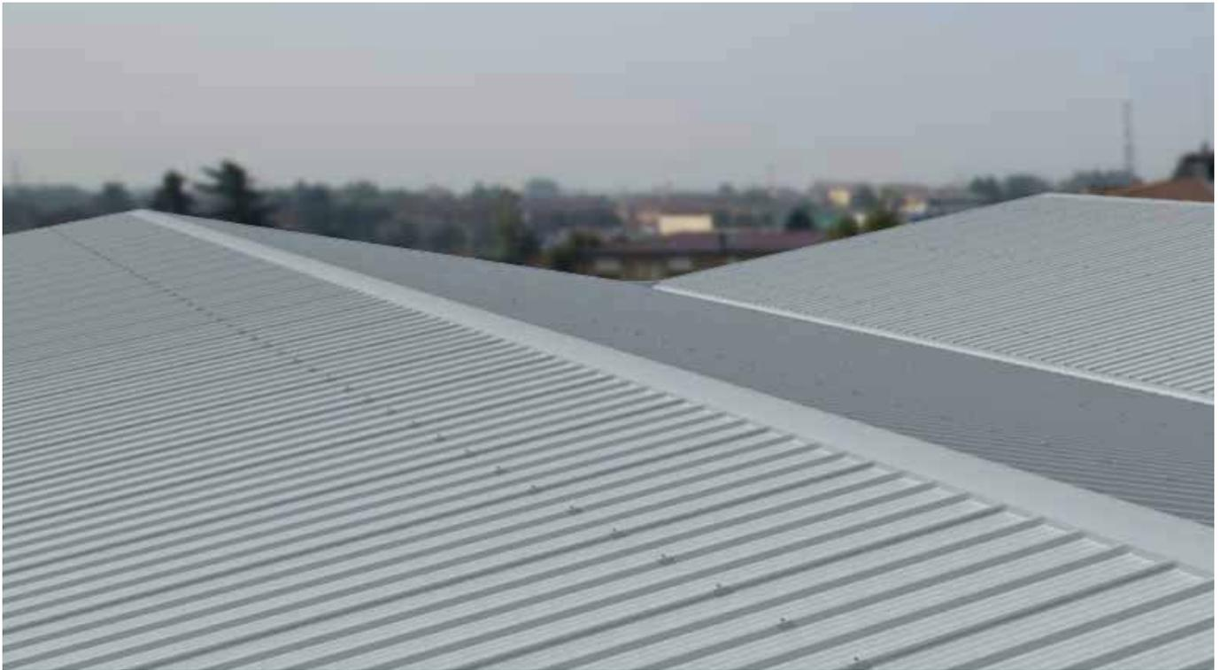
Pannello sandwich a doppio rivestimento metallico, per coperture con pendenza non inferiore a 7%, coibentato in poliuretano, con lamiera esterna profilata a 5 greche. Il fissaggio è a vista, con apposito cappellotto con guarnizione.
