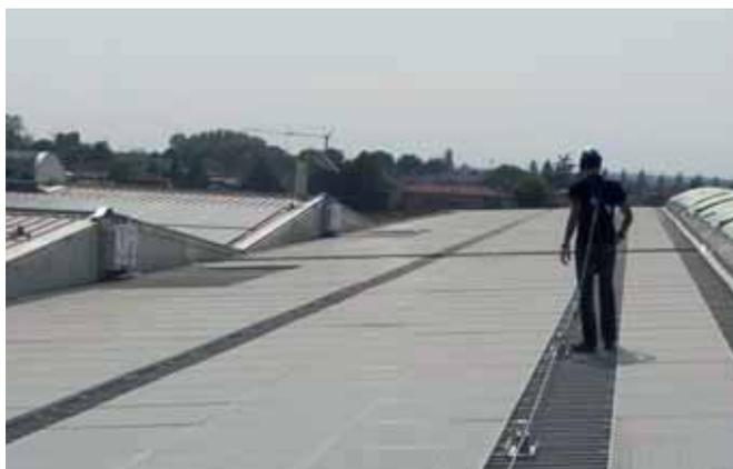
Il sistema ISOPAN SAFE BASE è un sistema di fissaggio a falda, il cui utilizzo è vincolato alla presenza di coperture realizzate con pannelli ISOCOP-5 1000 o ISODOMUS; sono disponibili 3 tipi di fissaggio, rispettivamente alla sottostruttura, alla sovrastruttura o ibrido.
