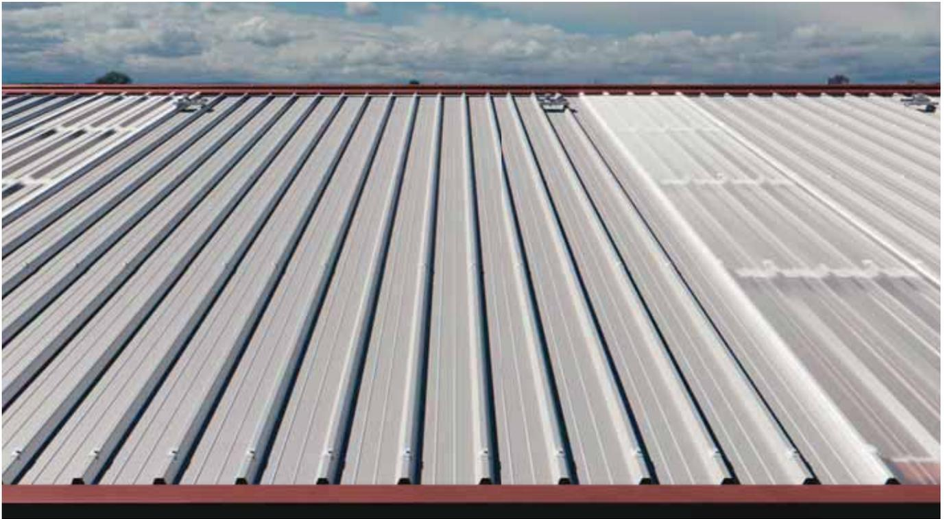
Pannello sandwich a doppio rivestimento metallico, per coperture con pendenza non inferiore a 7%, coibentato in poliuretano, con lamiera esterna profilata a 5 greche per aumentare la resistenza ai carichi statici e dinamici. Il fissaggio è a vista, con appositi cappellotti metallici e guarnizione. Trova impiego anche nel rivestimento di pareti.
