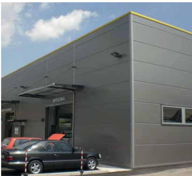
I sistemi R.A.C. (Raccordi Angolari Coibentati) sono elementi di finitura angolari studiati appositamente per pareti realizzate con i pannelli sandwich Isopan.
