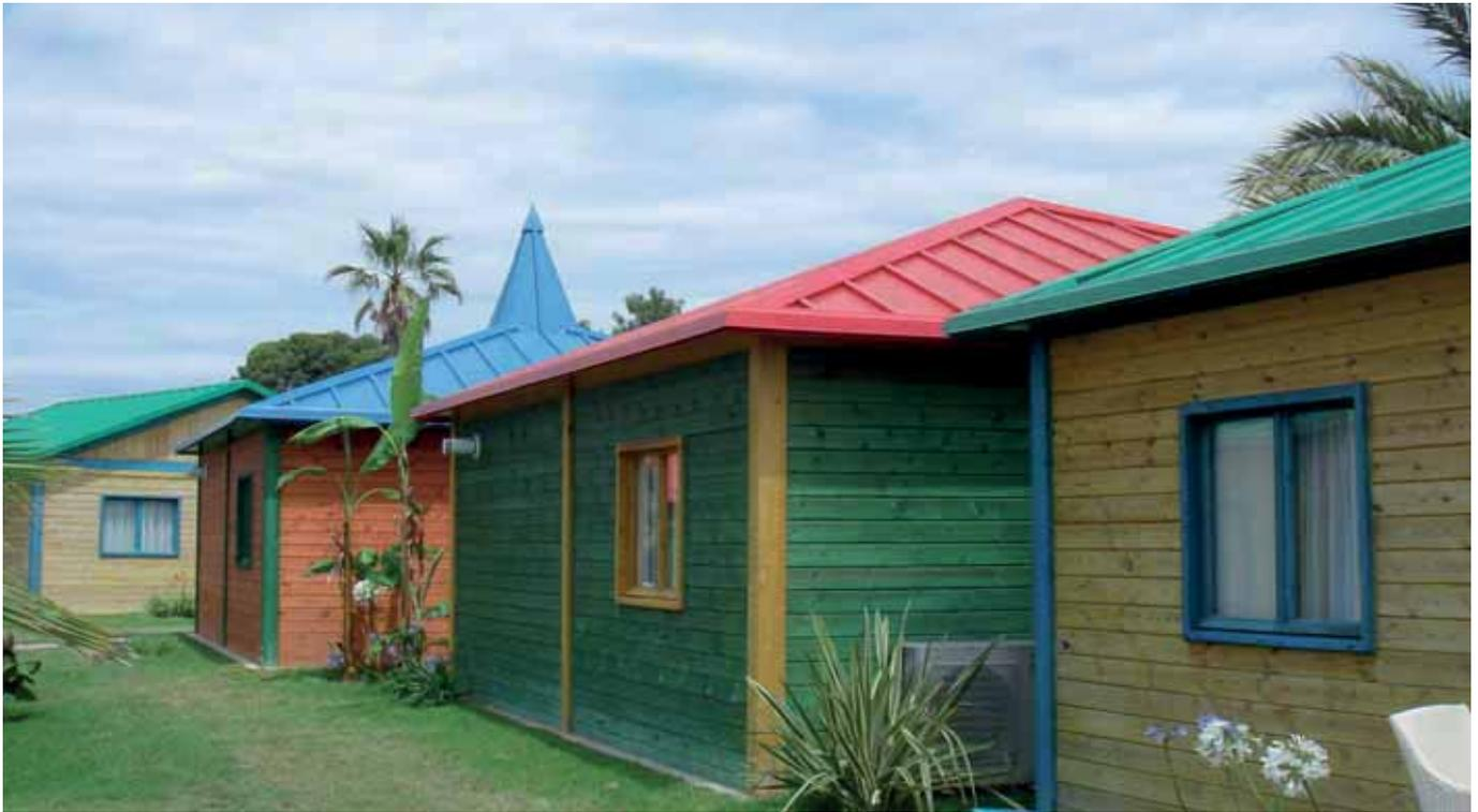
Pannello sandwich a doppio rivestimento metallico, per coperture con pendenza non inferiore a 7%, coibentato in poliuretano, con lamiera esterna profilata a 5 greche per aumentare la resistenza ai carichi statici e dinamici. Il fissaggio è di tipo nascosto, con apposito cappello copriunto a incastro.
