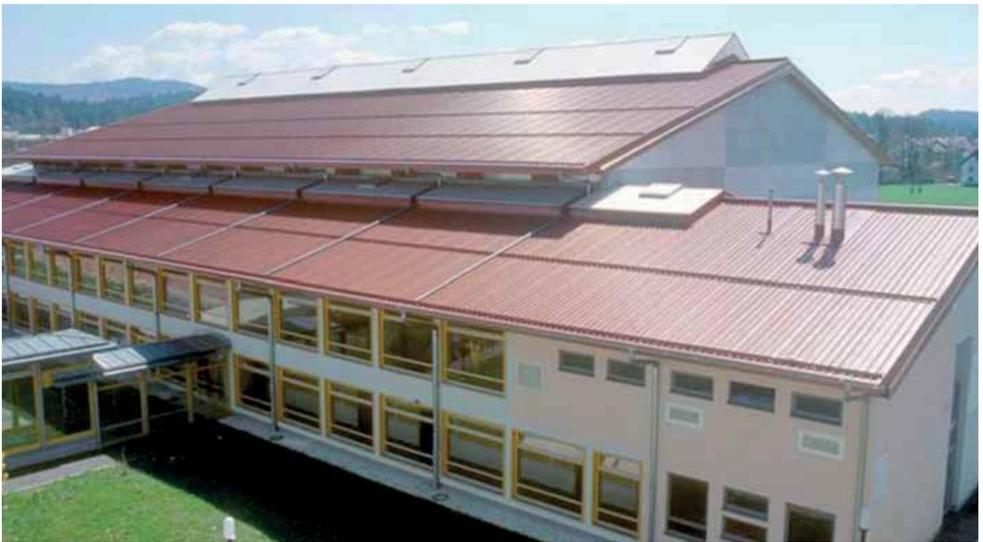
Pannello sandwich monolamiera, per coperture con pendenza non inferiore a 7%, coibentato in poliuretano, con lamiera esterna profilata a 5 greche per aumentare la resistenza ai carichi statici e dinamici. Il fissaggio è di tipo a vista, con apposito cappello con guarnizione. Il supporto interno è costituito da alluminio centesimale gofrato.
