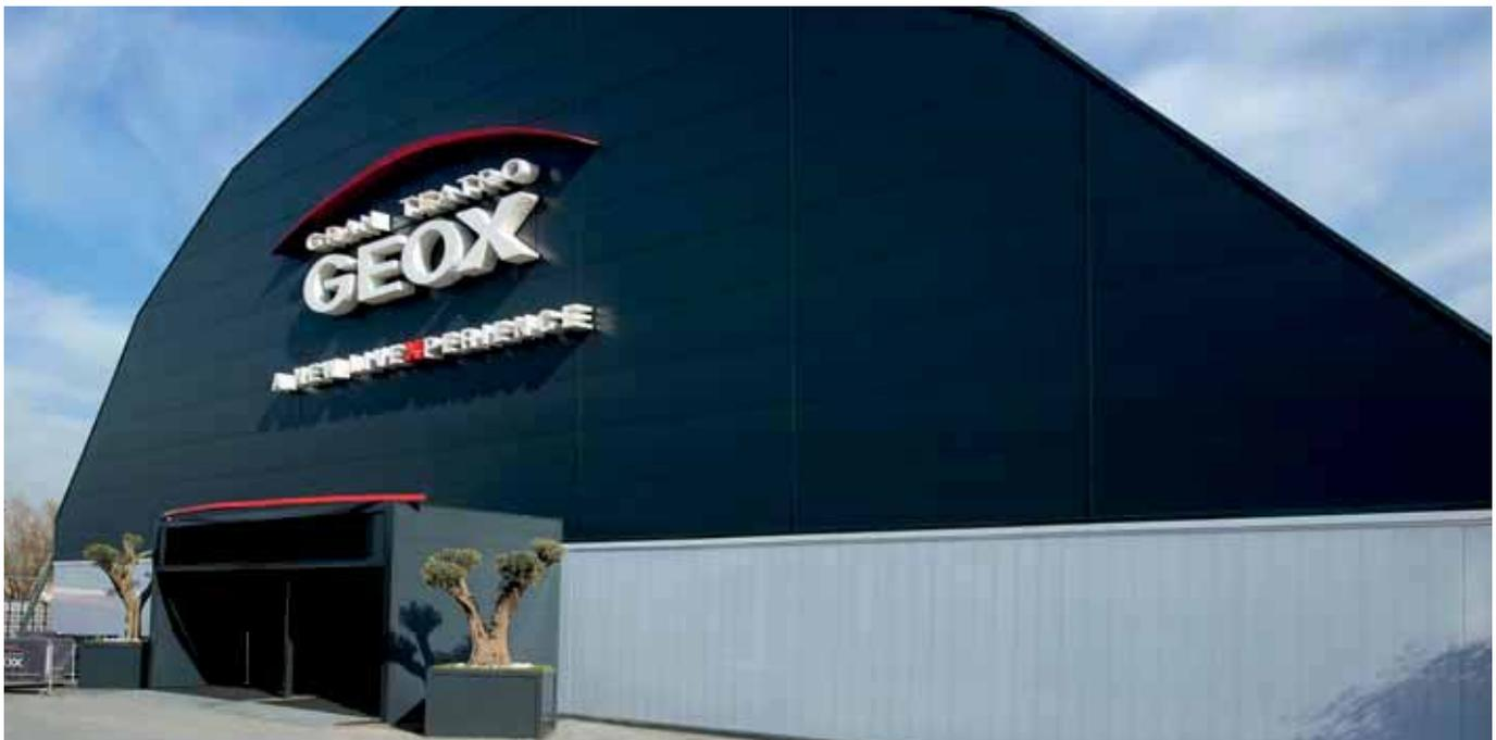
Pannello da parete a doppio rivestimento metallico con isolamento in poliuretano. Il giunto, con incastri maschio-femmina, è di tipo nascosto, con vite passante. Disponibile in diversi tipi di profilatura. Può essere utilizzato in accoppiamento con il pannello Isocalss.
