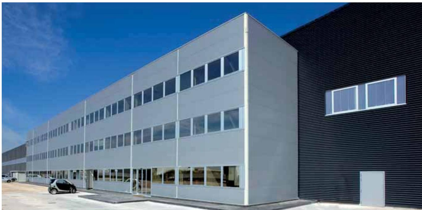
Pannello da parete a doppio rivestimento metallico con isolamento in poliuretano, dal profilo esterno ondulato. Il giunto, con incastri maschio-femmina, è di tipo nascosto, con vite passante. Disponibile in diversi tipi di profilatura. Può essere utilizzato in accoppiamento con i pannelli Isoparete Plissé e Isoparete Piano.
