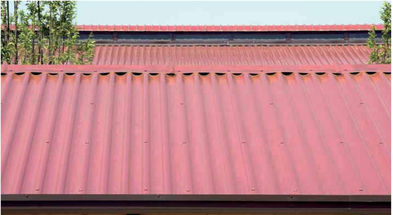
Pannello sandwich a doppio rivestimento metallico, per coperture con pendenza non inferiore a 7%, coibentato in poliuretano, con lamiera esterna profilata a 6 onde. Il fissaggio è di tipo a vista con appositi cappellotti e guarnizioni.
