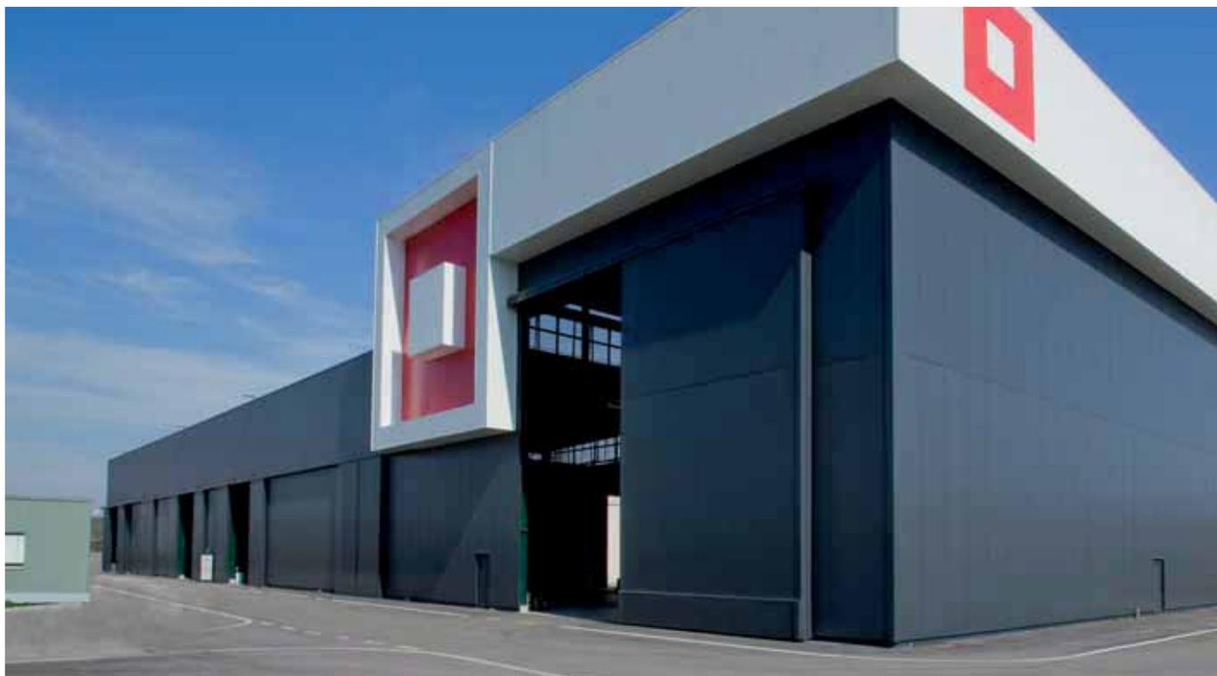
Pannello da parete a doppio rivestimento metallico con isolamento in lana minerale. Il giunto, con incastri maschio-femmina, è di tipo nascosto, con vite passante.
