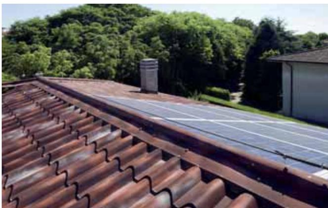
Il sistema ISOPAN SAFE STRUCTURAL è un sistema di fissaggio in colmo a base piana realizzabile in presenza di travi in legno, ferro e calcestruzzo.
