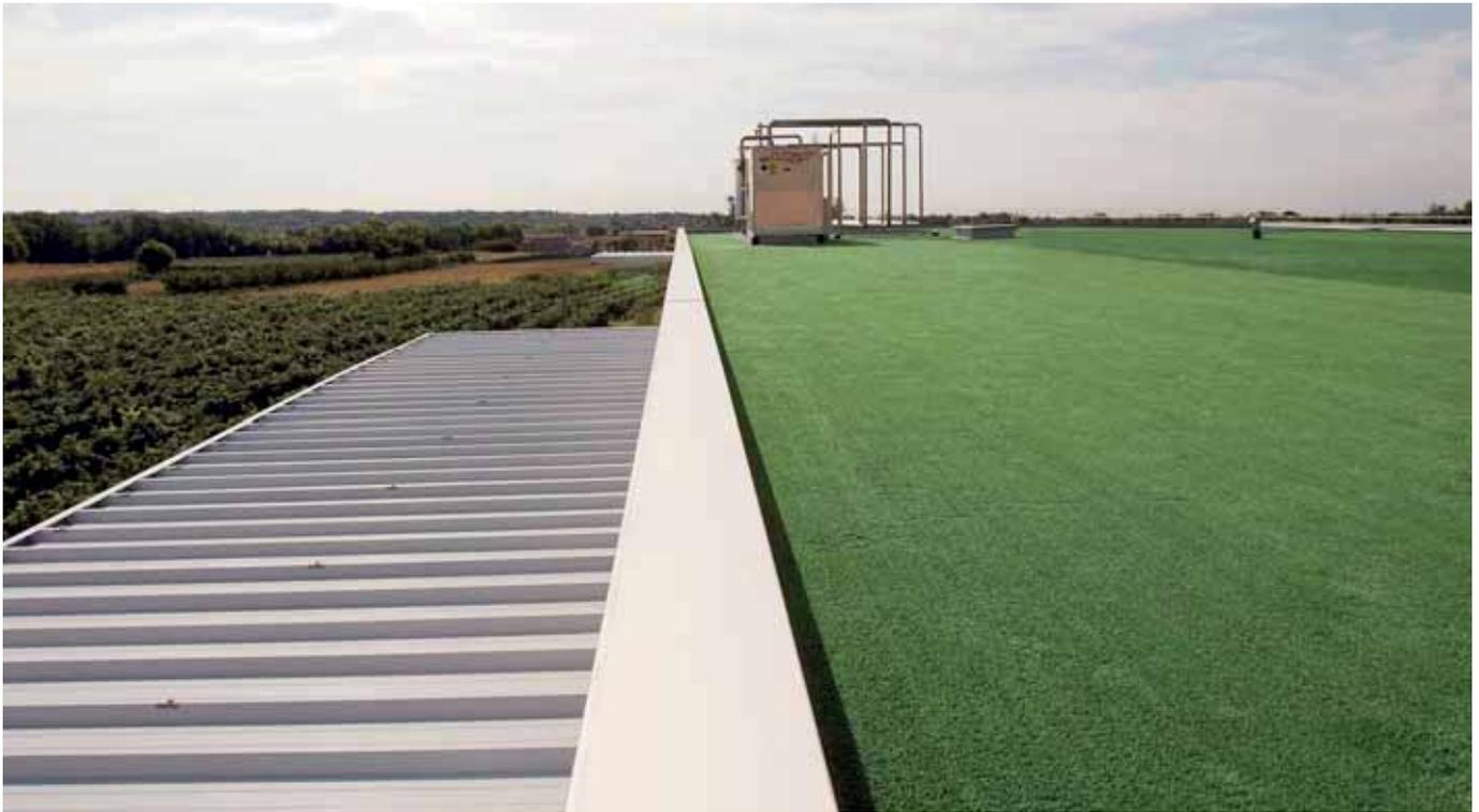
Pannello sandwich monolamiera, per coperture con pendenza non inferiore a 7%, coibentato in poliuretano, con lamiera esterna profilata a 5 greche per aumentare la resistenza ai carichi statici e dinamici. Il fissaggio è a vista, con apposito cappello con guarnizione. Può essere utilizzato per la realizzazione di coperture piane, grazie al supporto in cartofeltro bitumato.
