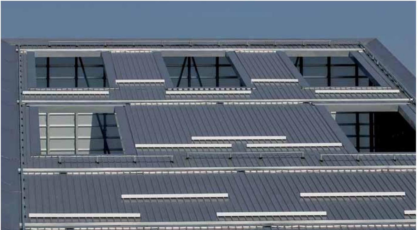
Pannello sandwich a doppio rivestimento metallico, per coperture con pendenza non inferiore a 7%, coibentato in lana minerale, con lamiera esterna profilata a 5 greche per aumentare la resistenza ai carichi statici e dinamici. Il fissaggio è di tipo a vista, con appositi cappellotti metallici con guarnizione.
